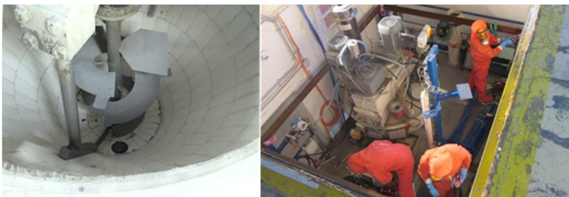
Figure 10. Installation de la cuve intermédiaire de 15 m 3 et montage de son agitateur.
