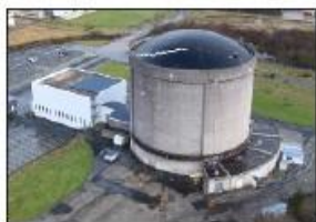
2 - Brennilis Finistère, à 70 km de Brest Réacteur à eau lourde Mise en service : 1967 Date d'arrêt : 1985 Décret MAD/DEM partiel : 2011
