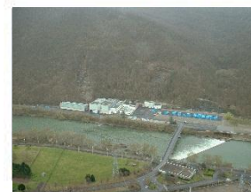
1 - Chooz Ardennes, à 60 km de Charleville-Mézières Réacteur à eau pressurisée Mise en service : 1967 Date d'arrêt : 1991 Décret MAD/DEM : 2007
