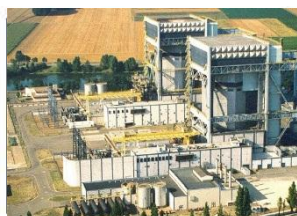
3 - Saint Laurent A Loir-et-Cher, à 35 km d'Orléans 2 réacteurs UNGG Mises en service : 1969 et 1971 Dates d'arrêt : 1990 et 1992 Décret MAD/DEM : 2010
