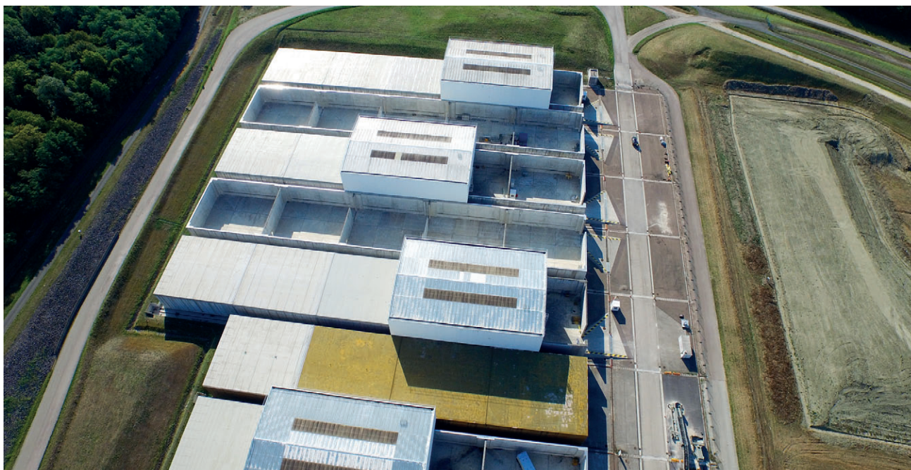
Centre de stockage de l'Aube.
