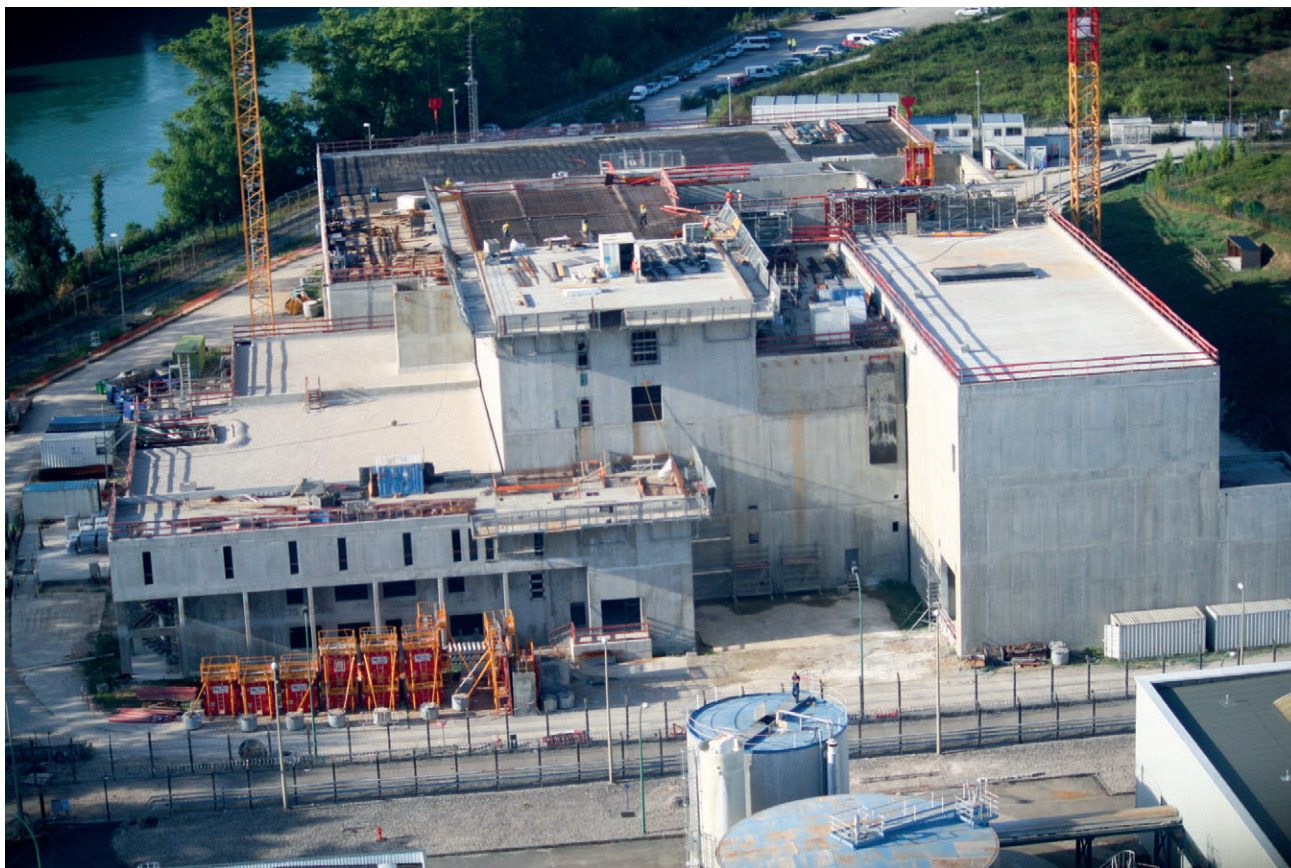
Chantier de construction d'Iceda, août 2015.
