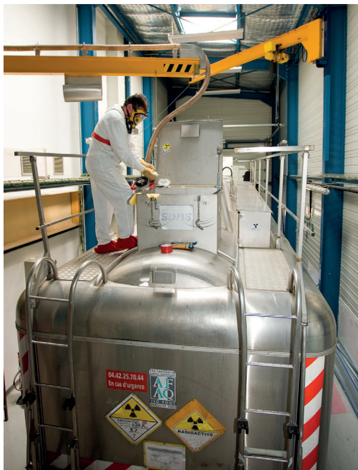
Station de traitement des effluents (STE) – INB 37-B – CEA Cadarache.
