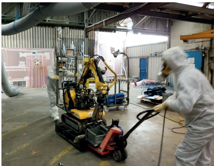
Site de l'usine de Feursmetal (Loire), en cours de décontamination.
