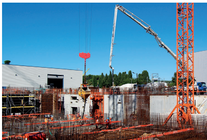
Chantier de Diadem.
