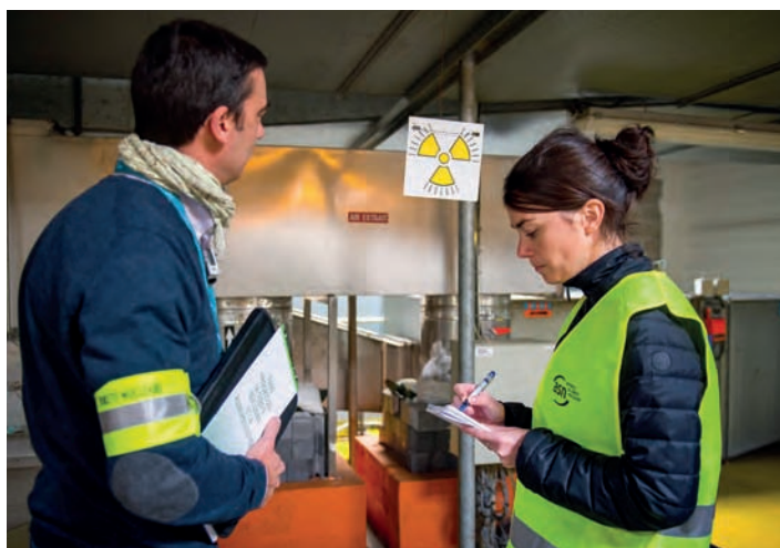
Inspection de l'ASN dans l'installation Ionisos à Sablé-sur-Sarthe, novembre 2016.
