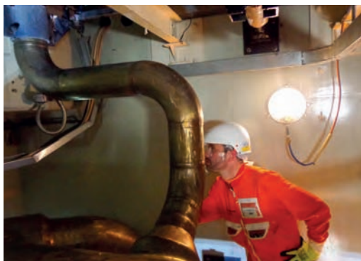
Épreuve hydraulique du circuit primaire du réacteur 4, centrale nucléaire de Cruas-Meysses, mai 2016.
