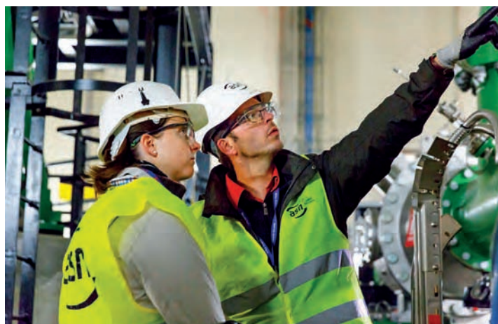
Inspection de l'ASN lors des essais de démarrage du système SRU, Flamanville 3, octobre 2016.
