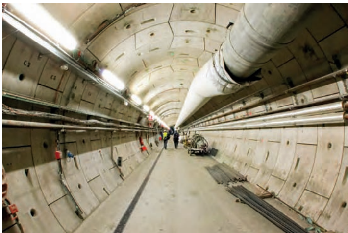
Laboratoire souterrain de Meuse/Haute-Marne : galerie de conception rigide.
