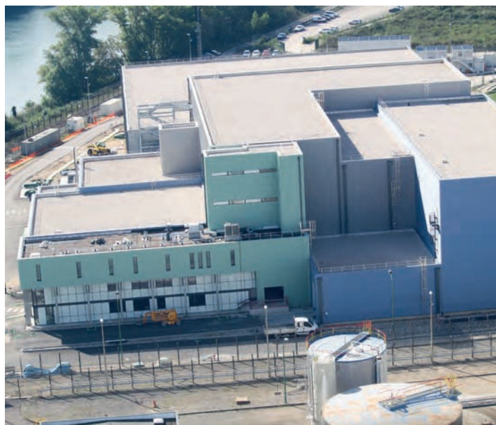
Chantier de construction d'Iceda, 2016.
