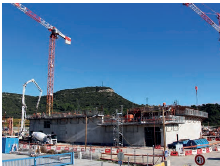
Chantier de Diadem, novembre 2016.
