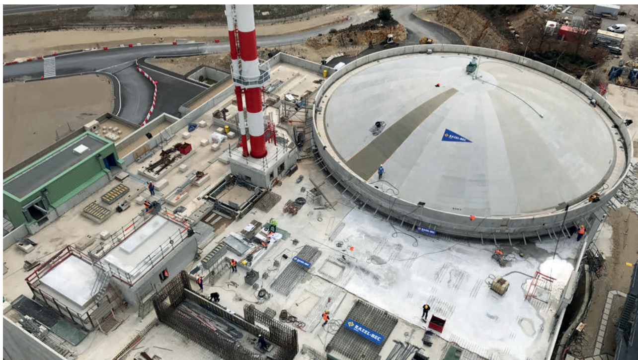
Travaux de toiture sur le RJH, mars 2017.
