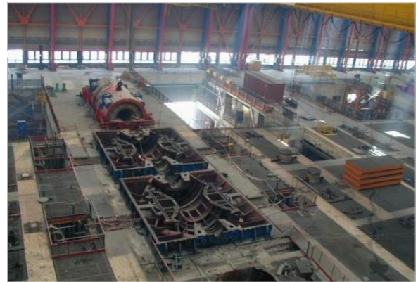
Démantèlement de la salle des machines, source : EDF
