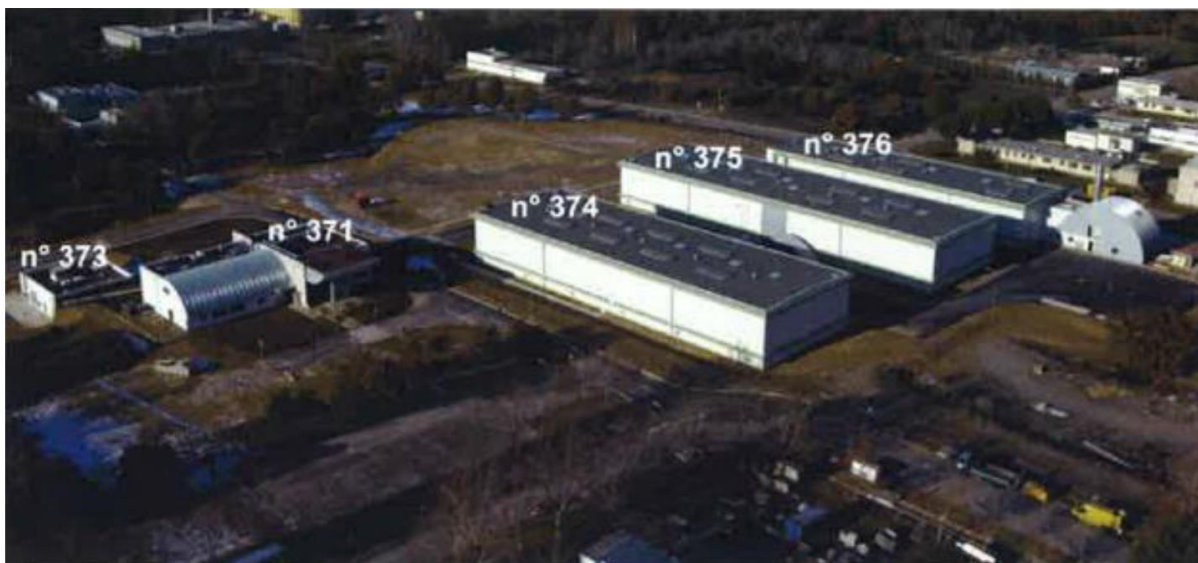
Figure 2 : Vue générale de l'installation Cedra
