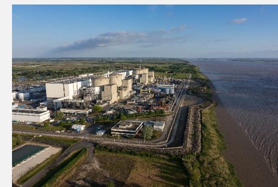
Centrale de Blayais – refroidissement en circuit ouvert
