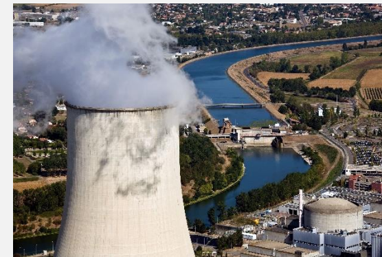
Centrale de Golfech – refroidissement en circuit fermé (tours aéroréfrigérantes)
