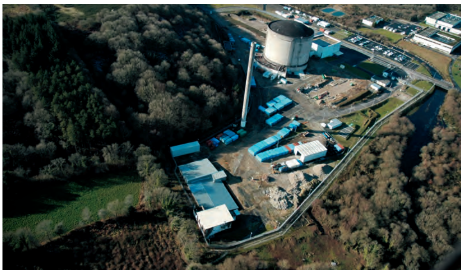
Vue aérienne du site de la centrale de Brennilis (Finistère)
