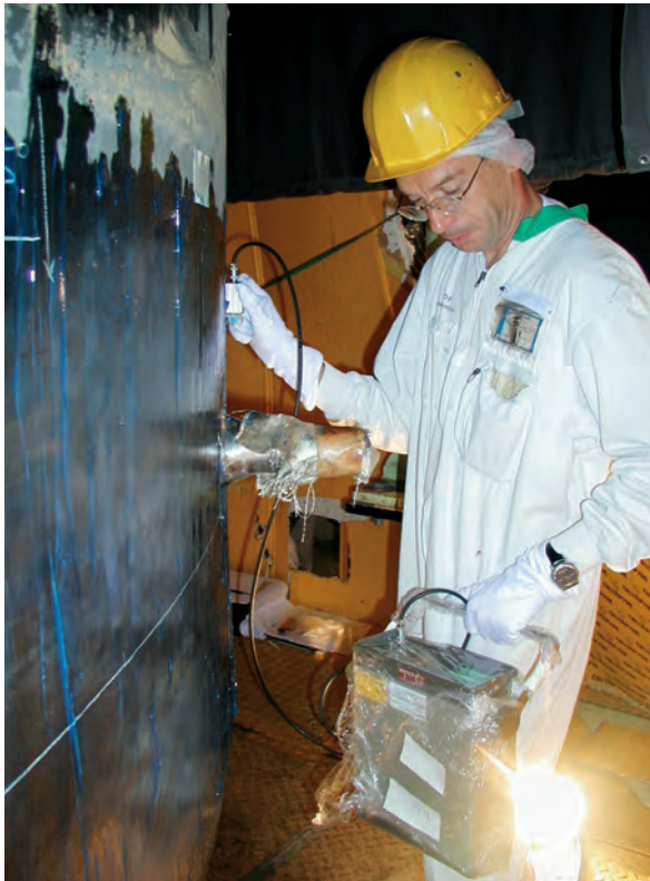
Contrôle par ultrasons d'un joint soudé
