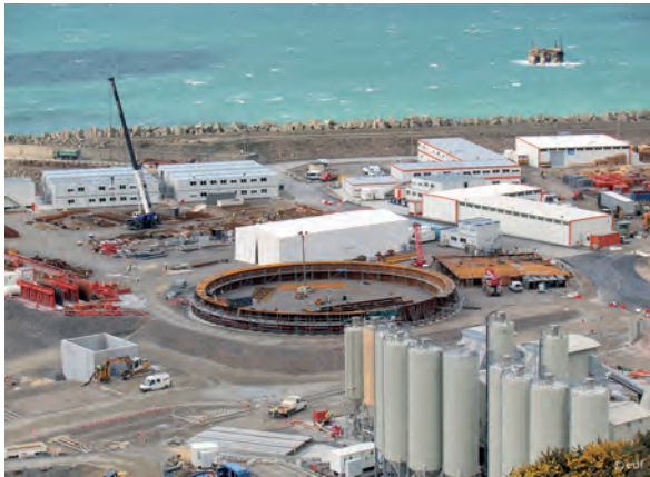
Chantier de construction de l'EPR à Flamanville (Manche) – Mars 2008 : assemblage sur place de la peau d'étanchéité métallique interne de l'enceinte de confinement du réacteur
