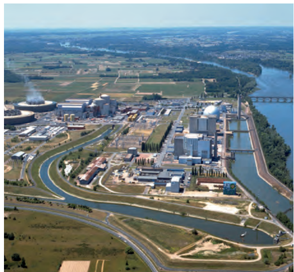
Vue du site de la centrale nucléaire de Chinon (Indre-et-Loire)
