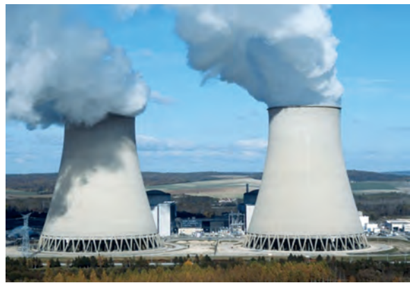
Tours aéroréfrigérantes de la centrale nucléaire de Nogent-sur-Seine (Aube) : les aérosols émis sont susceptibles de contenir des légionelles
