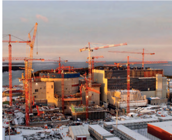
Chantier de l'EPR d'Olkiluoto (Finlande) – Janvier 2009
