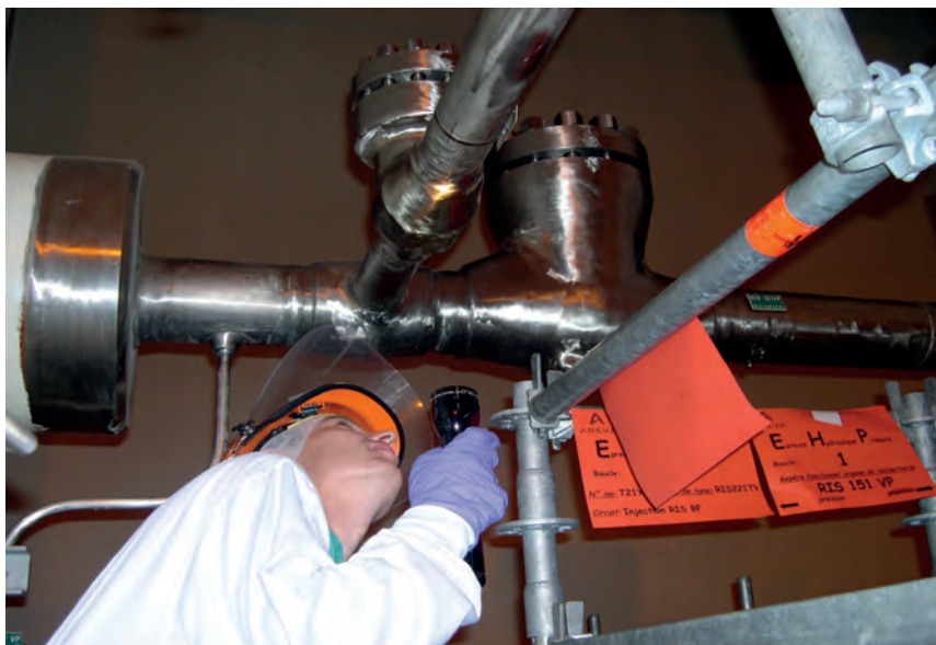
Contrôle des tuyauteries par l'inspecteur de l'ASN lors de l'épreuve hydraulique du circuit primaire à Cattenom (Moselle) – Juin 2008
