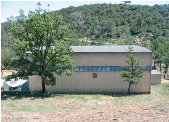
Vue du bâtiment du réacteur HARMONIE à Cadarache (Bouches-du-Rhône) avant son démantèlement
