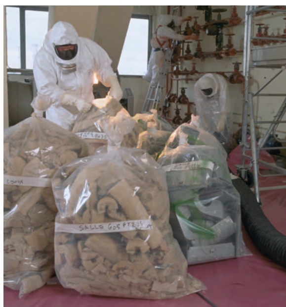
Démantèlement de la centrale de Brennilis (Finistère) arrêtée depuis 1985 – opération de décalorifugeage de tuyauterie en salle 605 dans la station de traitement des effluents – janvier 1998
