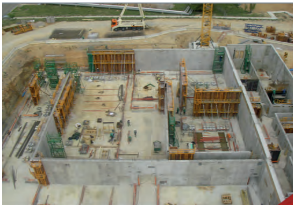
Vue du chantier de construction de l'installation MAGENTA
