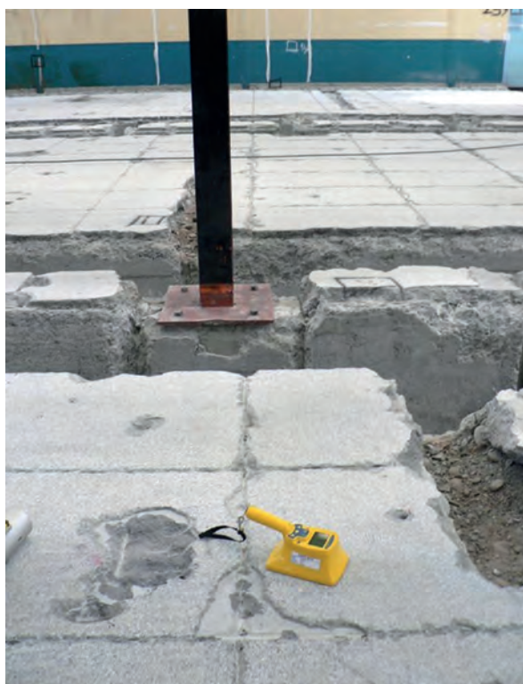
Installation nucléaire à La Hague sur laquelle ont été réalisées des opérations d'assainissement complet
