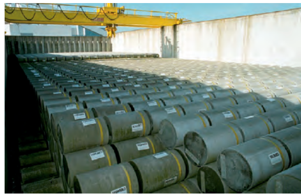
Entreposage des fûts de déchets dans l'atelier ADT – AREVA NC à La Hague (Manche)
