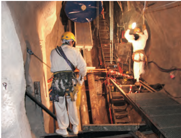
Opérateurs travaillant au démantèlement du conduit de ventilation du réacteur de Chooz (Ardennes)
