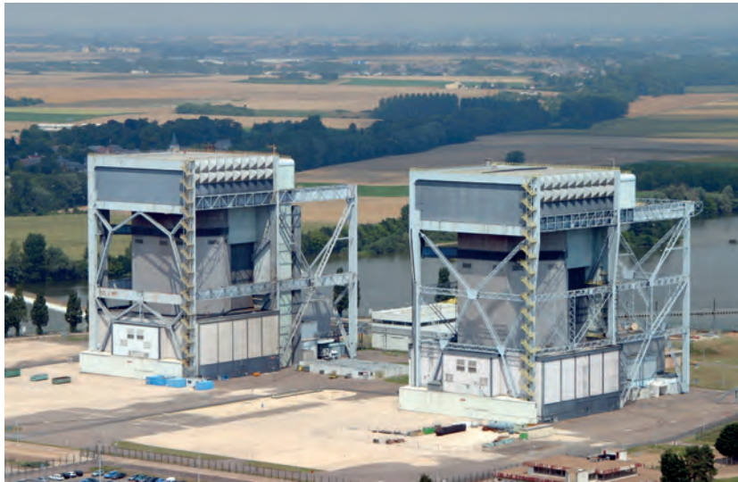
Les deux caissons des réacteurs graphite-gaz de la centrale nucléaire de Saint-Laurent-des-Eaux (Loir-et-Cher)
