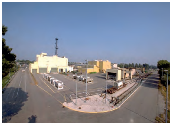
Vue de l'installation TU5 sur le site du Tricastin
