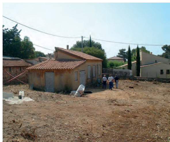
Site de la propriété Danne à Bandol (Var)
