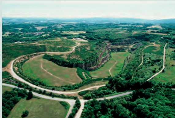
L'ancien site minier de Bellezane après son réaménagement
