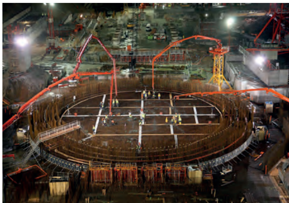
Chantier de construction de l'EPR à Flamanville (Manche) – Décembre 2007 : coulage du radier de l'îlot nucléaire
