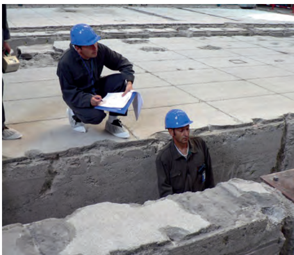
Inspecteurs de la division de Lyon et de la DRD de l'ASN réalisant une inspection pour le déclassement du bâtiment C de SICN à Veurey-Voroize (Isère)
