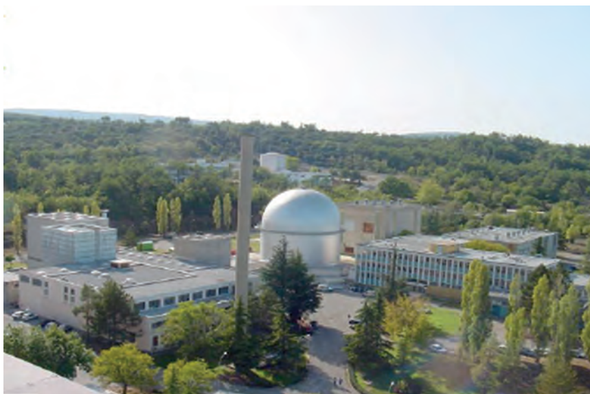
Vue du bâtiment du réacteur RAPSODIE à Cadarache (Bouches-du-Rhône)
