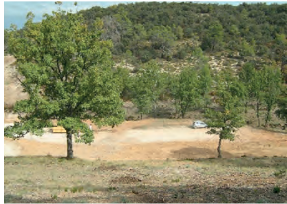
Vue du site du réacteur HARMONIE à Cadarache (Bouches-du-Rhône) après le démantèlement de l'installation
