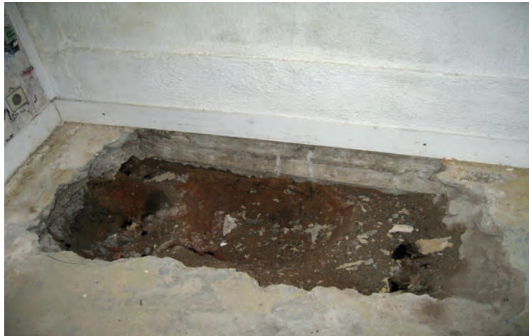
Intérieur d'une habitation du quartier des Coudraies à Gif-sur-Yvette après réalisation d'opérations d'assainissement
