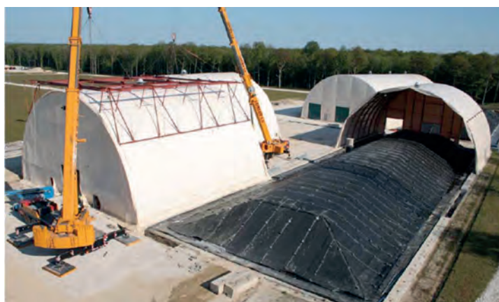
Opérations de fermeture d'alvéoles et de déplacement de la toiture mobile sur le site de Morvilliers (Aube)
