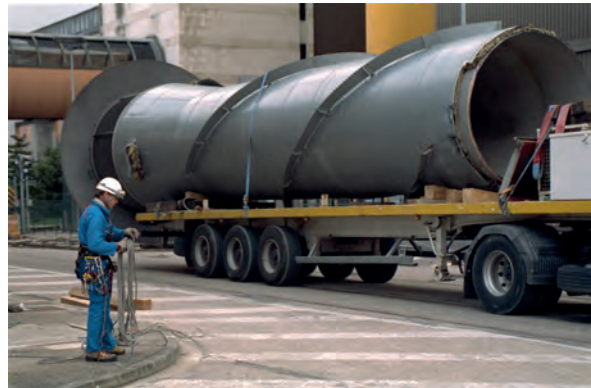
Mise en place sur un semi-remorque d'une cheminée découpée lors des opérations de démantèlement du réacteur SUPERPHÉNIX (Isère)
