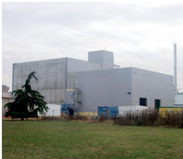
Bâtiment de l'extension STELLA de l'INB 35 à Saclay (Essonne)
