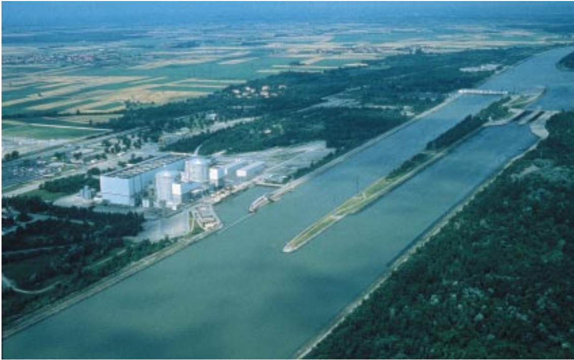
Centrale de Fessenheim
