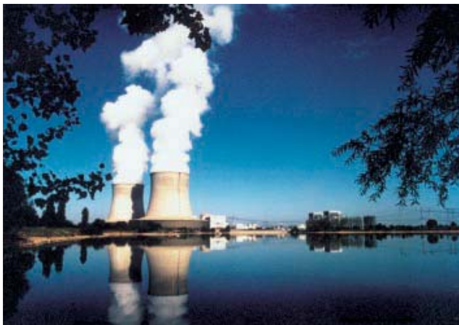
Centrale de Saint-Laurent-des-Eaux
