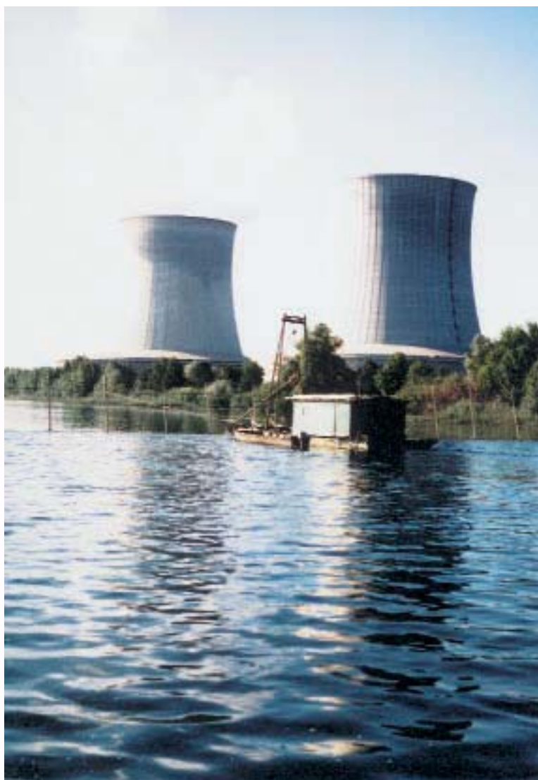
Centrale de Saint-Laurent-des-Eaux
