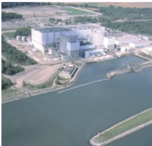
Centrale de Fessenheim
