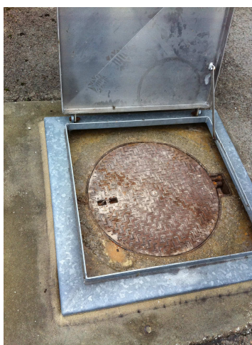
Photo prise de l'extérieur illustrant une action d'amélioration réalisée par l'exploitant : la trappe d'accès d'origine est recouverte par une deuxième trappe destinée à empêcher l'eau de pluie de s'infiltrer dans les galeries
