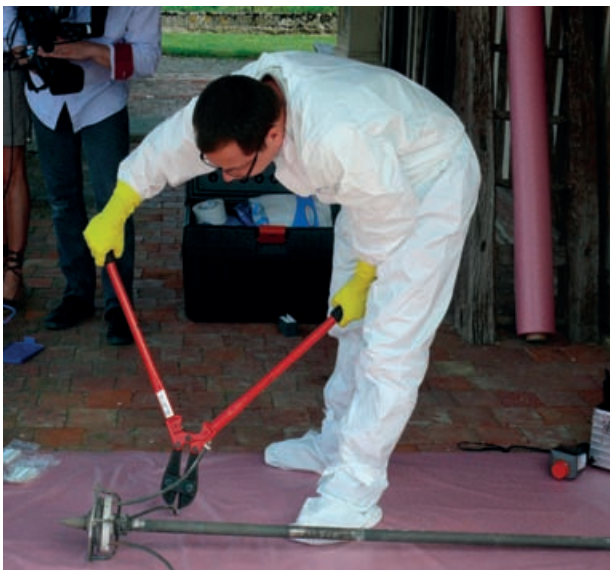
Découpe de la tête d'un paratonnerre au radium
