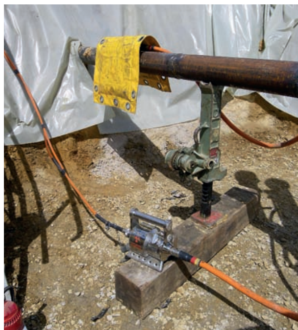
Appareil de gammagraphie sur chantier
