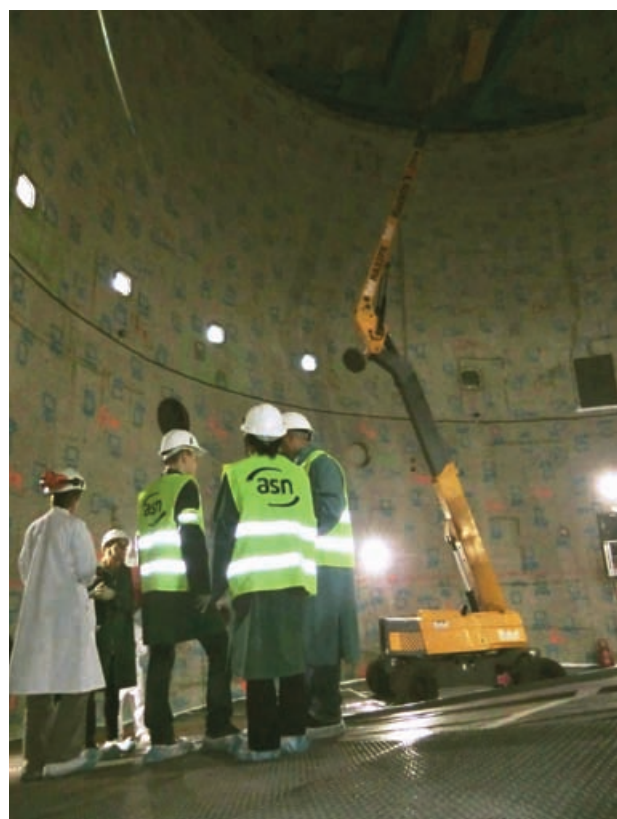
Inspection de déclassement du zonage déchets du dôme et du mur cylindrique du réacteur SILOÉ – Juin 2012
