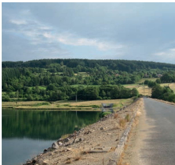
Digue des Bois Noirs (Loire)
