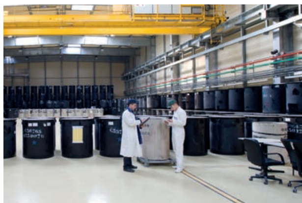
Hall d'entreposage de CEDRA
