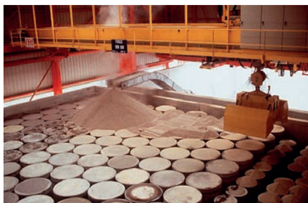
Phase de gravillonnage d'un ouvrage de stockage au CSA
