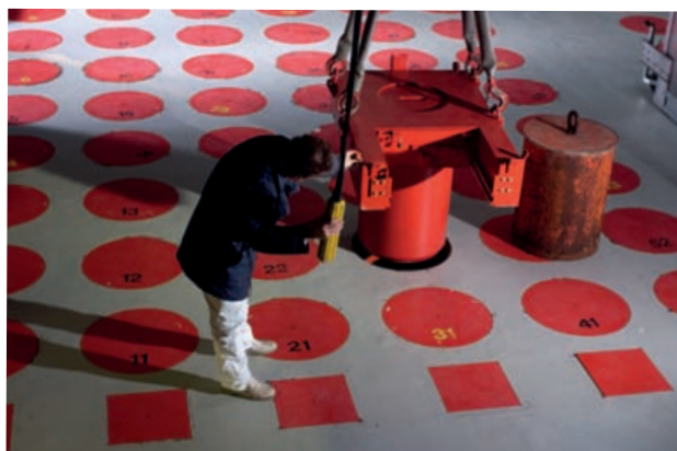
Hall d'entreposage des déchets sur l'INB 72
