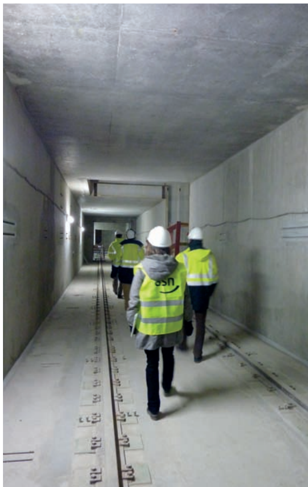
Inspection de l'ASN sur le chantier suspendu d'ICEDA – Décembre 2012
