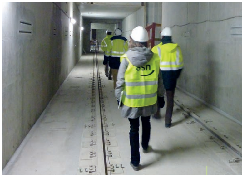
Inspection de l'ASN sur le chantier suspendu d'ICEDA - Décembre 2012
