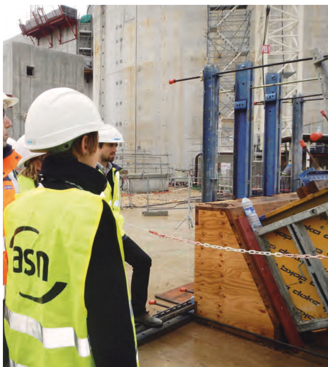
Inspection de l'ASN sur le chantier du réacteur Jules Horowitz (RJH), novembre 2014.
