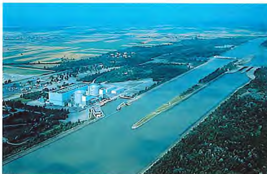
Centrale de Fessenheim
