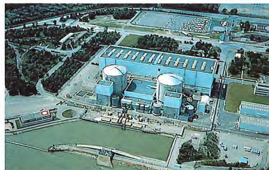
Centrale de Fessenheim
