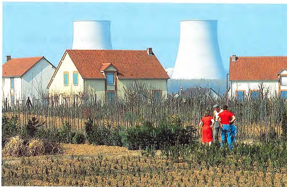
Centrale de Nogent-sur-Seine
