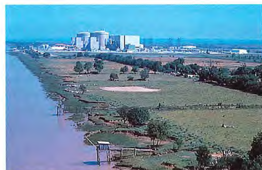
Centrale du Blayais
